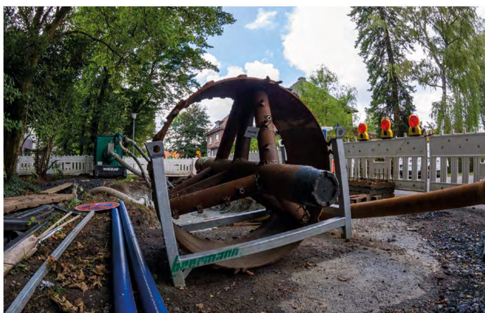
Mit jedem Aufweitungsbohrkopf wird das Bohrloch bis zum gewünschten Durchmesser vergrößert.
