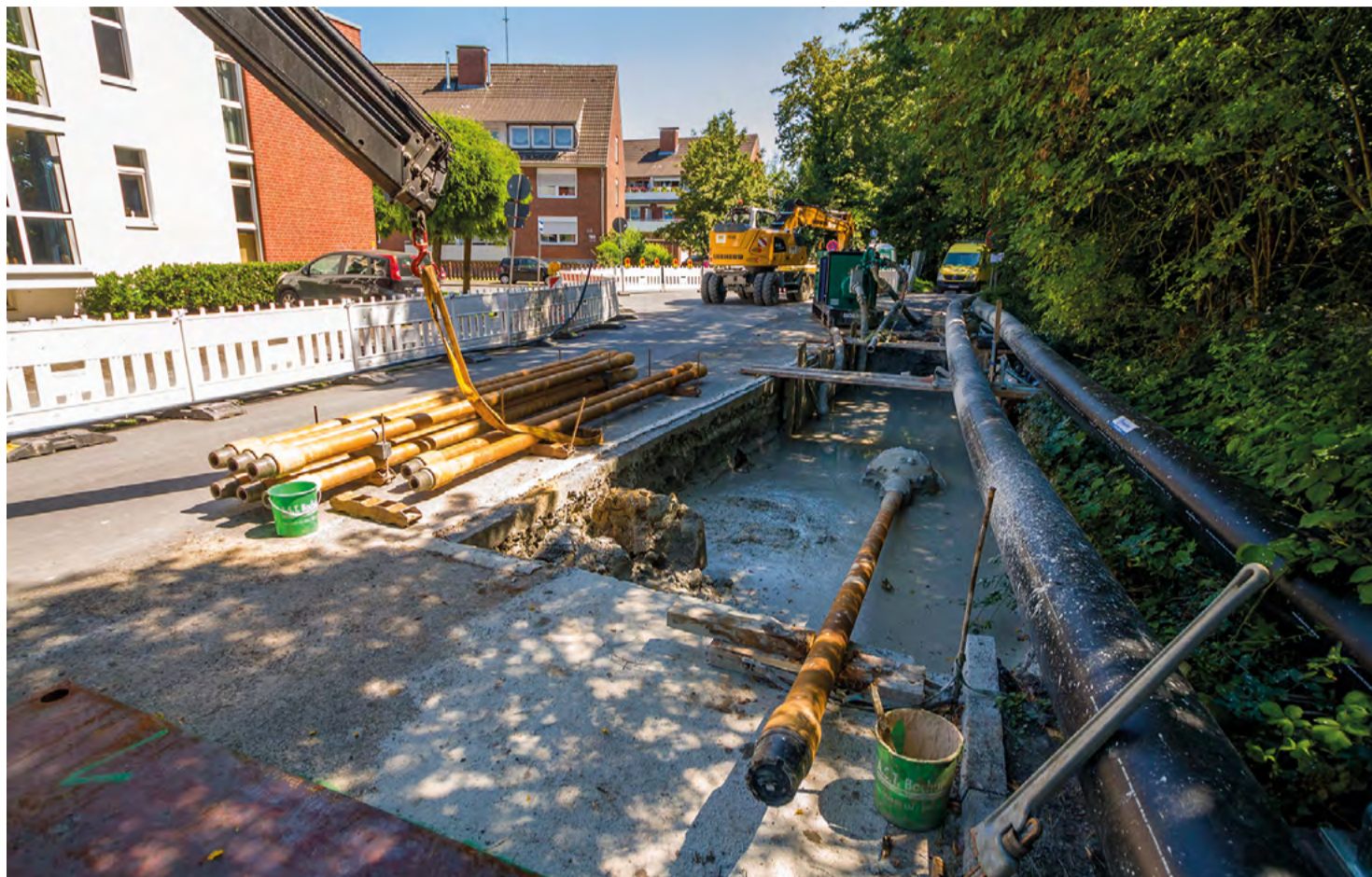
Von der Zielgrube aus erfolgen die Aufweitungen des Bohrloches in Richtung der Startgrube.
