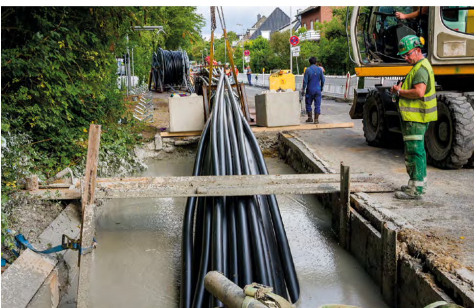
Die einzelnen Schutzrohre werden als komplettes Leitungsbündel in das Bohrloch eingezogen.
