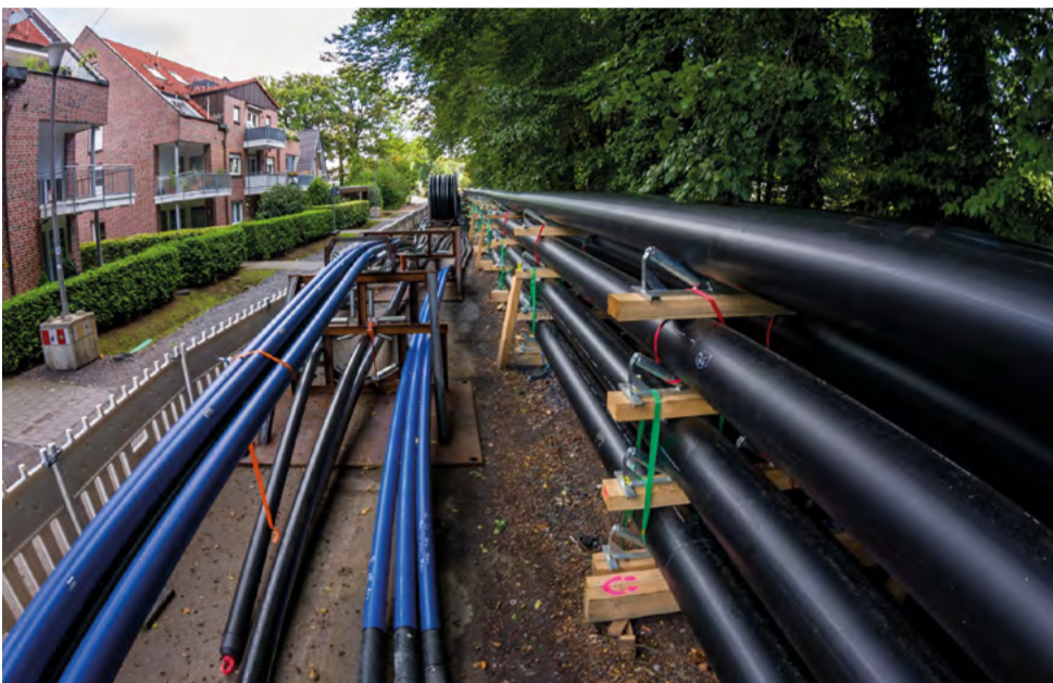
Die Schutzrohre DA 355 wurden zunächst zu längeren Rohrsträngen zusammenschweißt und bis zur Bündelung mit den anderen Schutzrohren übereinander entlang der Einzugsstrasse zwischengelagert.
