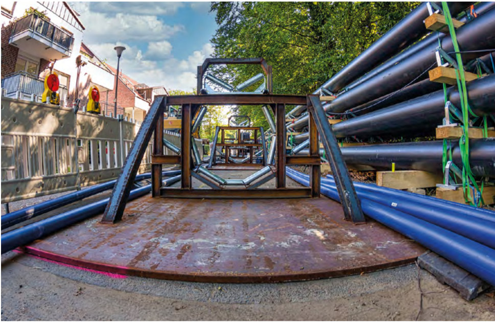
Die Abrollvorrichtungen dienen zur Bündelung der einzelnen Schutzrohre.
