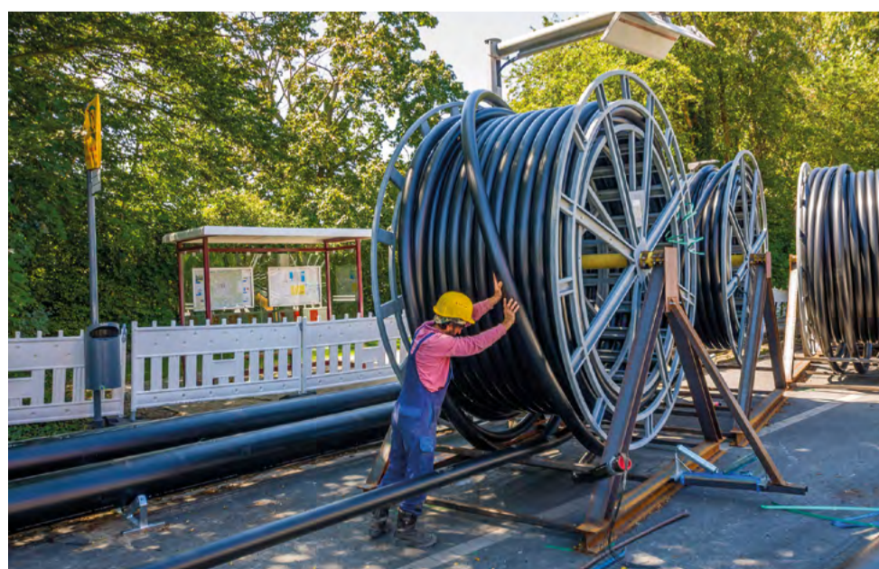
Auf den bis zu 3,20 Meter durchmessenden Trommeln wurden die kleineren Schutzrohre angeliefert und nach den CAD-Planungen für die Bündelung gelagert.
