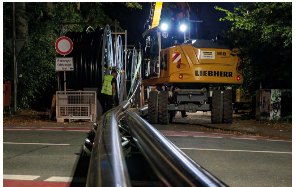
Damit die Schutzrohre komplett ausgelegt werden konnten, waren zahlreiche Straßensperrungen notwendig.
