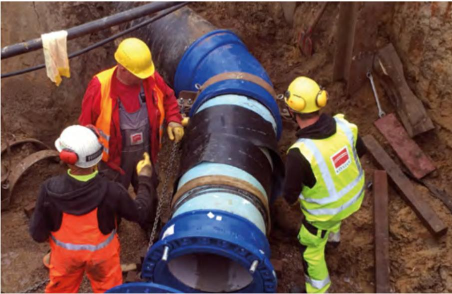
Den vielen Abwinkelungen im Trassenverlauf wurde durch den Einsatz von längskraftschlüssigen Zug-/Schubsicherungen und HPVi-Dichthalteringen Rechnung getragen.
