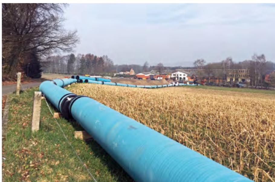
Die mit Zementmörtel ausgekleideten und zusätzlich mit ZMU umhüllten duktilen Gussrohre DN 600 (PN 16) wurden entlang der Trasse bis zum Einbau gelagert.
