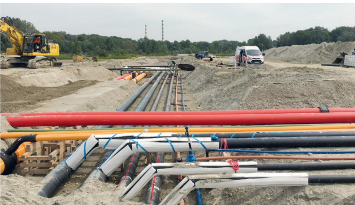
Durch die unterschiedlichen Leitungen wird der IN-Campus zu einem sogenannten Nullenergie-Campus: Ermöglicht wird dies durch das LowEx-Rohrleitungssystem, das als Ringnetz verlegt wird und allen Gebäuden auf dem Campus als Wärmequelle und Wärmesenke dient.
