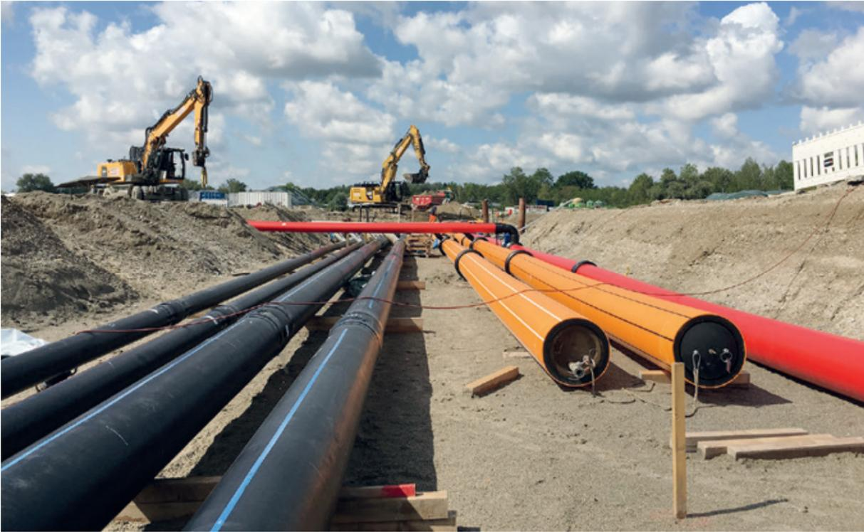
Alle Leitungen liegen auf einer Höhe und werden in einem mehr als 10 Meter breiten Rohrgraben verlegt.
