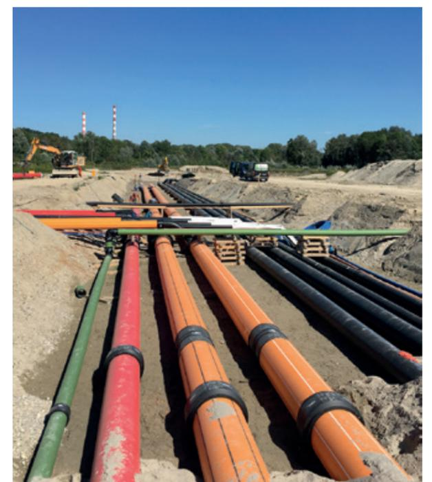
Durch unterschiedliche Farben mit individuellen Streifen und einer exakten Beschriftung können die Rohrleitungen auch später eindeutig dem entsprechenden Medium zugeordnet werden.
