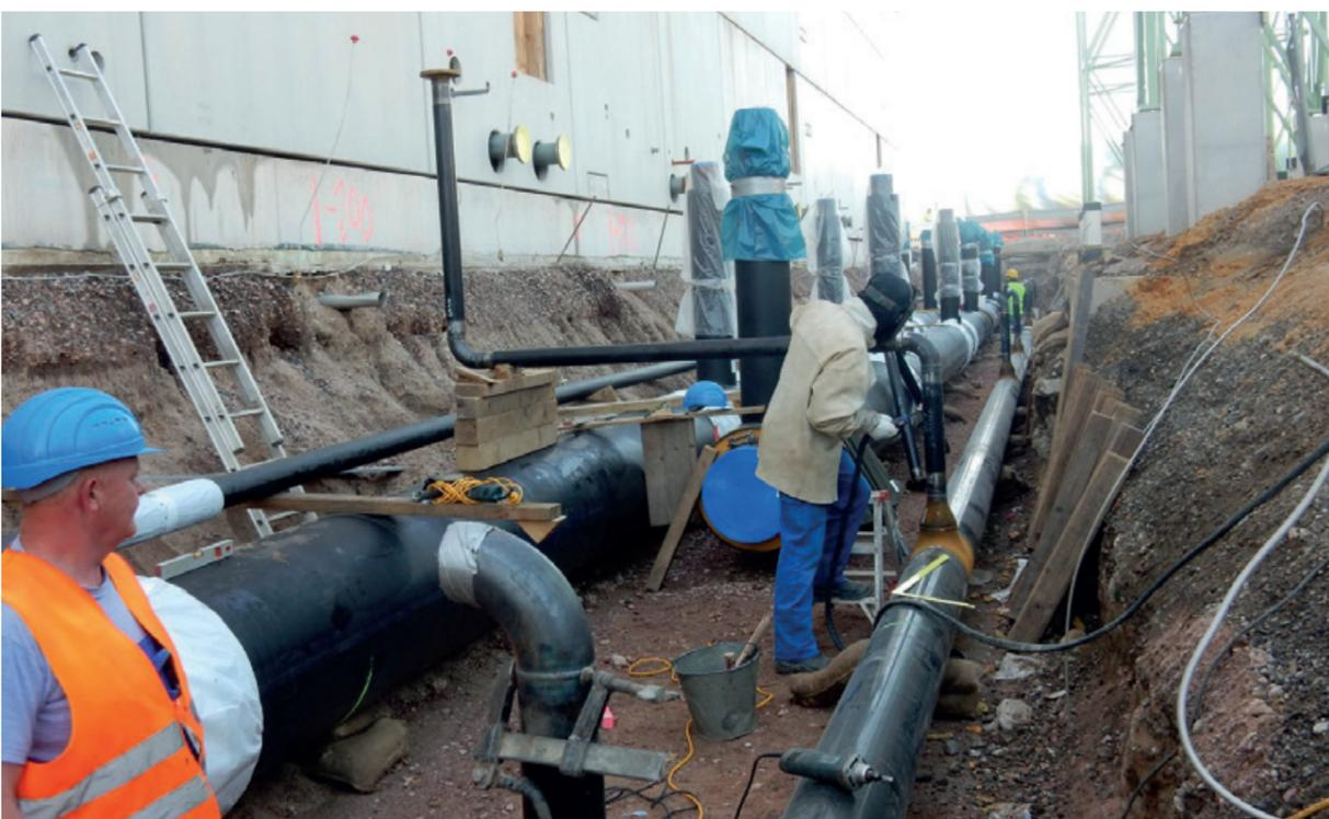
Die Gas-HD-Leitung verläuft hauptsächlich entlang des Neubaus und hat zehn Abgänge DN 80 zum Anschluss der Gasmotoren.
