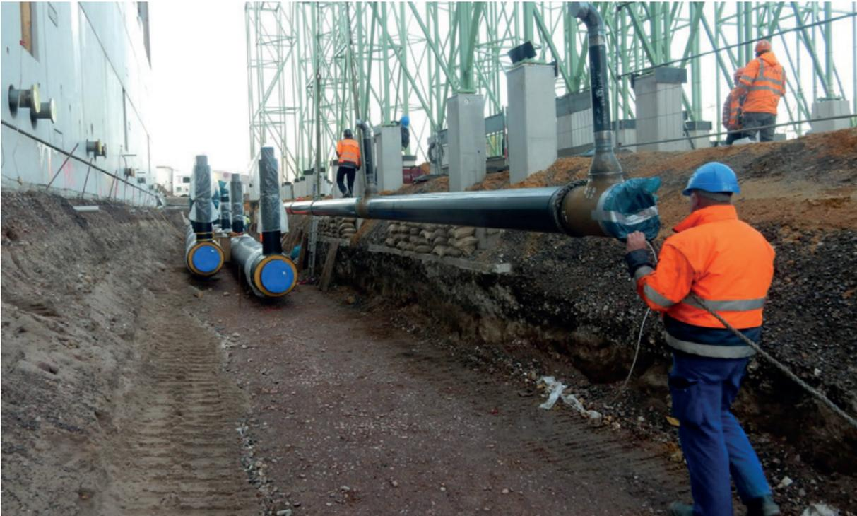
Auf der Ingelheimer Aue in Mainz wurde ein neues 100-MW-Blockheizkraftwerk errichtet, das mit seinen 10 Gasmotoren Strom und Fernwärme für das gesamte Stadtgebiet Mainz liefern wird. Zum Speisen der Gasmotoren mit H-Gas hat die bauausführende Südwestdeutsche Rohrleitungsbau GmbH eine Gasleitung HD DN 250 verlegt. (Fotos: SWR GmbH)
