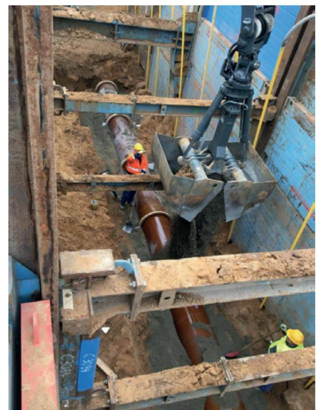
**Die Steinzeugrohre für die Schmutzwasserkanäle wurden bis über Rohrscheitel mit steinfreiem Sand verfüllt. Danach konnte das Rohraufleger für die Betonrohre des Regenwassersammlers hergestellt werden.**
