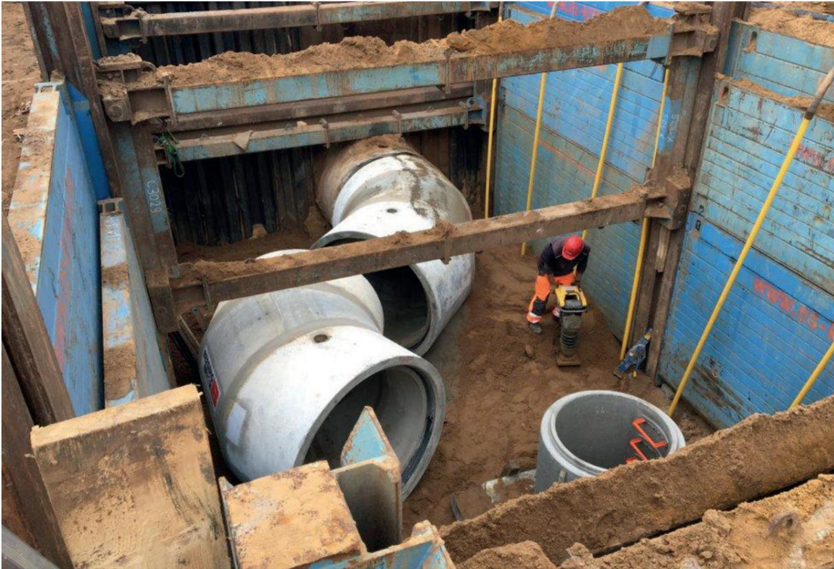
Die Laufwagen können entsprechend den statischen Vorgaben des Herstellers in der Höhe verfahren werden. Das sorgt für einen ausreichend großen Arbeitsraum für das Verlegen der Rohre.
