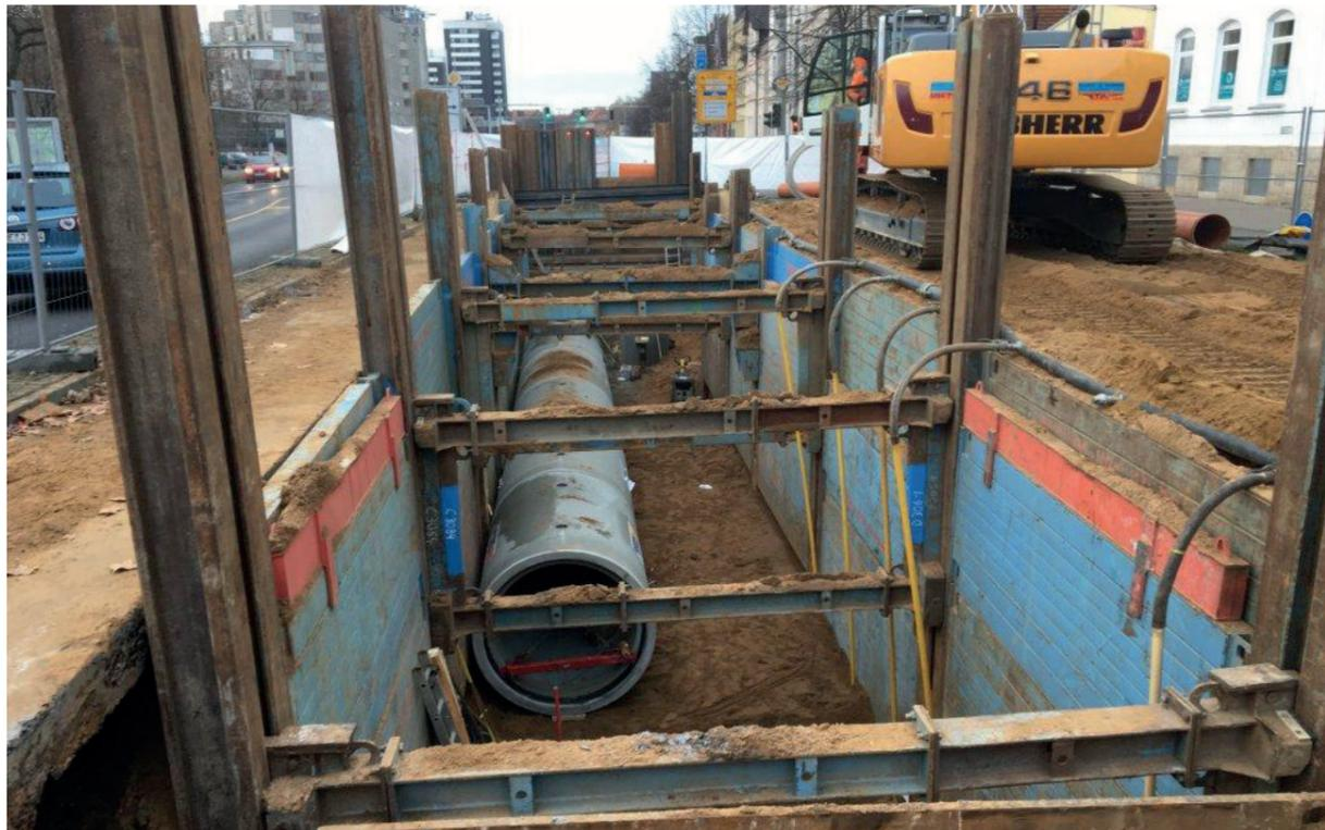
**Grabenbreite immer gleich:** Das Linearverbauensystem besteht aus einzelnen Schienen, in denen Platten senkrecht in ebener oder gestufter Anordnung geführt werden. Die gegenüberliegenden Schienen werden durch einen biegesteifen, in der Breite veränderbaren Laufwagen auf dem gewünschten Abstand gehalten. (Fotos: STRATIE Bau GmbH)
