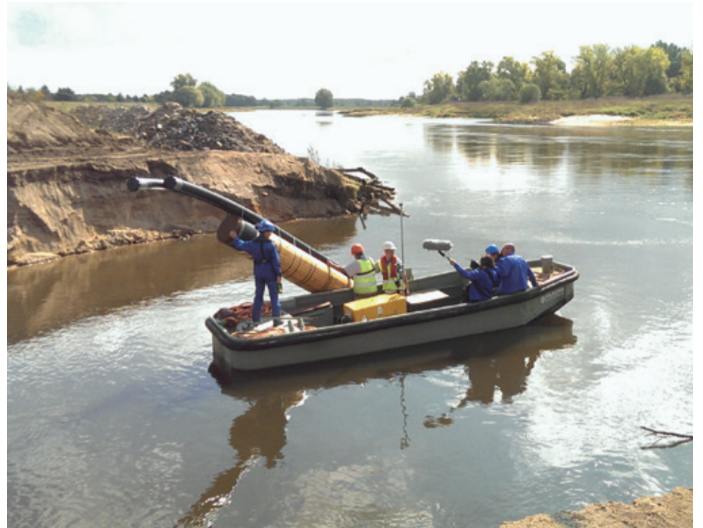
Nach dem erfolgreichen Einzug wurde der neue Düker getauft. (Foto: Bohlen &amp; Doyen / PRT Berlin Brandenburg)
