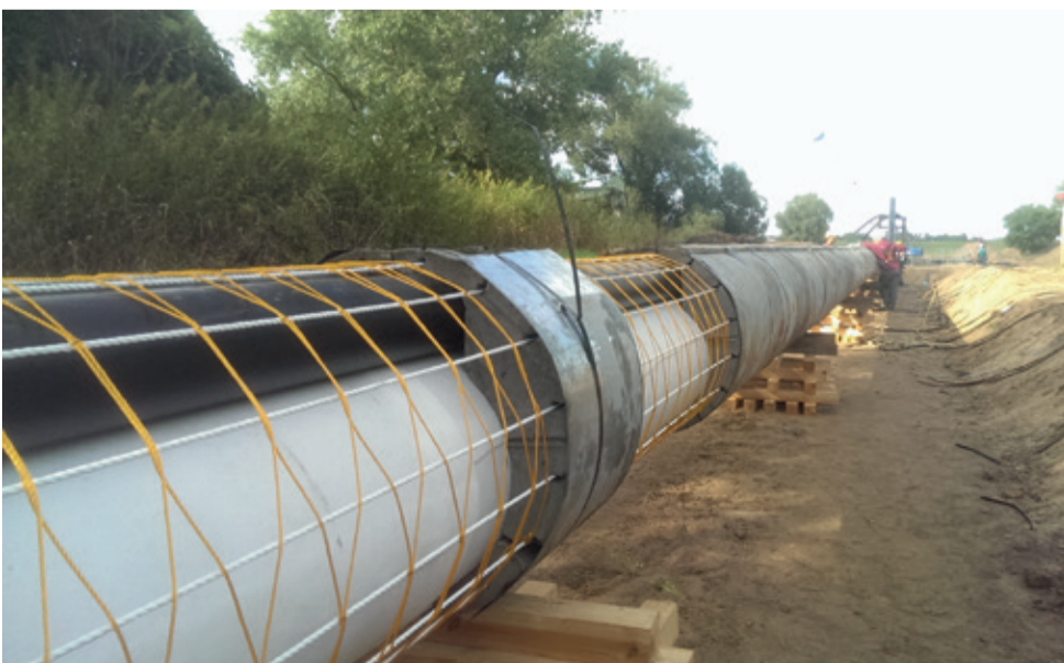
Der neue Düker wurde bei der Montage an Land mit Abstandshaltern aus Beton und einer Bewehrung aus Kunststoffelementen ausgestattet. (Foto: Bohlen & Doyen / PRT Berlin Brandenburg)
