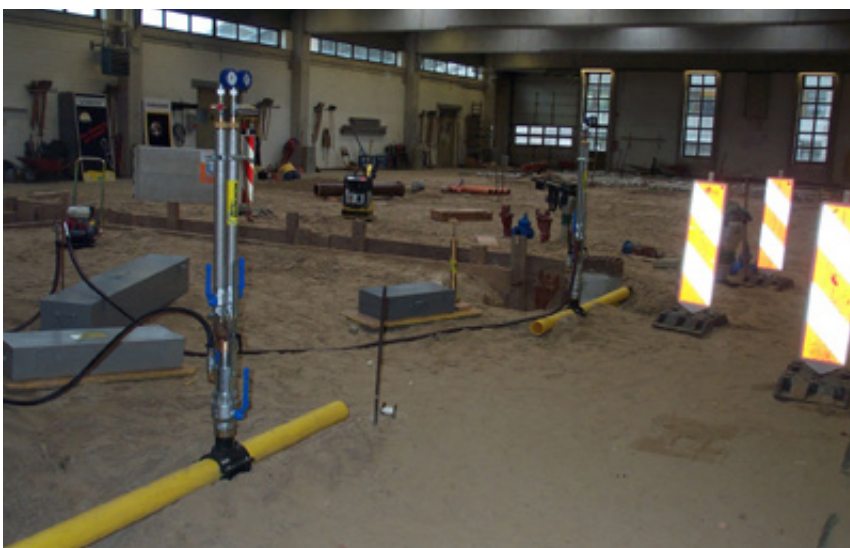
Abb. 5 – Leitungssperrung mittels Blasensetzgerät
