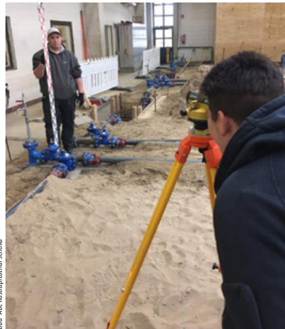
Abb. 1 – Einmessung erdverlegter Leitungen mit Schieberkreuz nach DVGW-Arbeitsblatt GW 128
