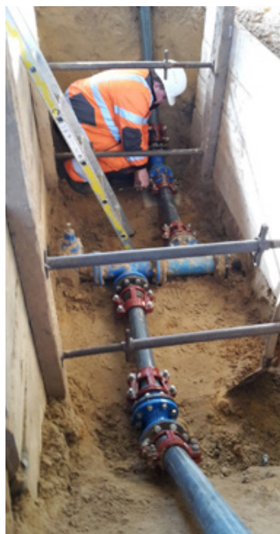
Abb. 3 – Längskraftschlüssige Leitungsverlegung
