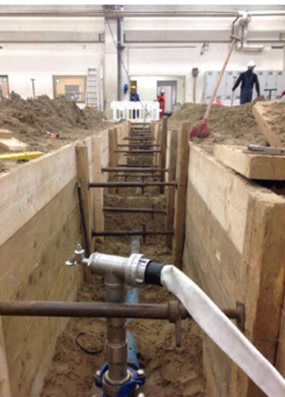
Abb. 2 – Spülung und Probenahme an einer Wasserleitung
