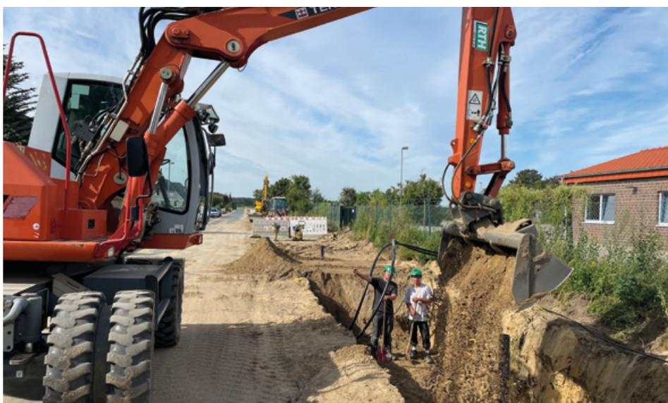
Baugrabenverfüllung mit Bodenmaterial von der Bereitstellungsfläche
