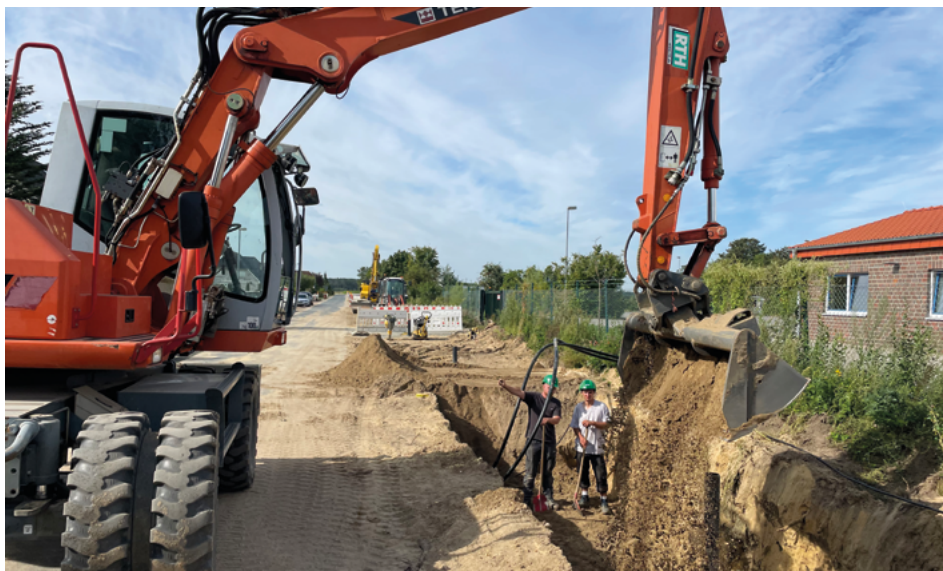
Baugrabenverfüllung mit Bodenmaterial von der Bereitstellungsfläche
