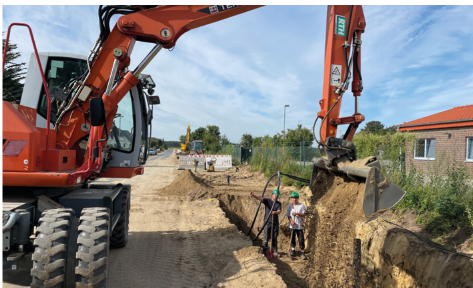
Baugrabenverfüllung mit Bodenmaterial von der Bereitstellungsfläche
