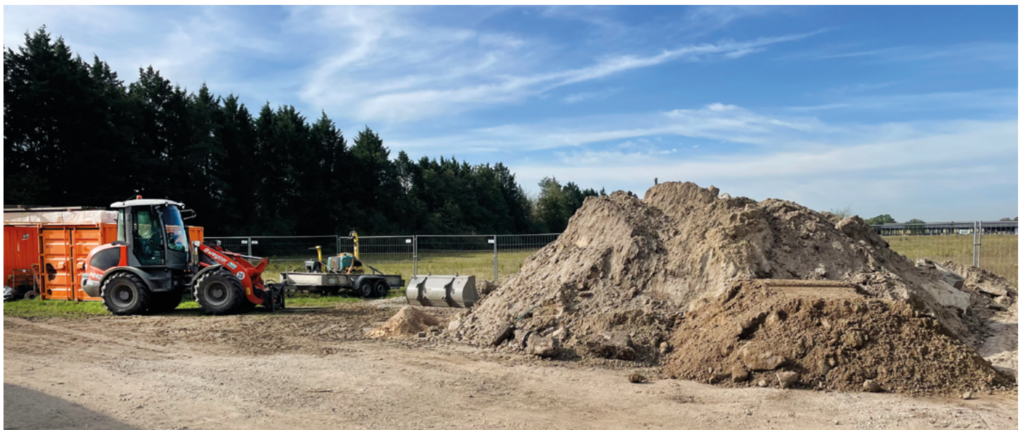
Lagerung von Bodenmaterial auf der Bereitstellungsfläche der Baustelleneinrichtung
