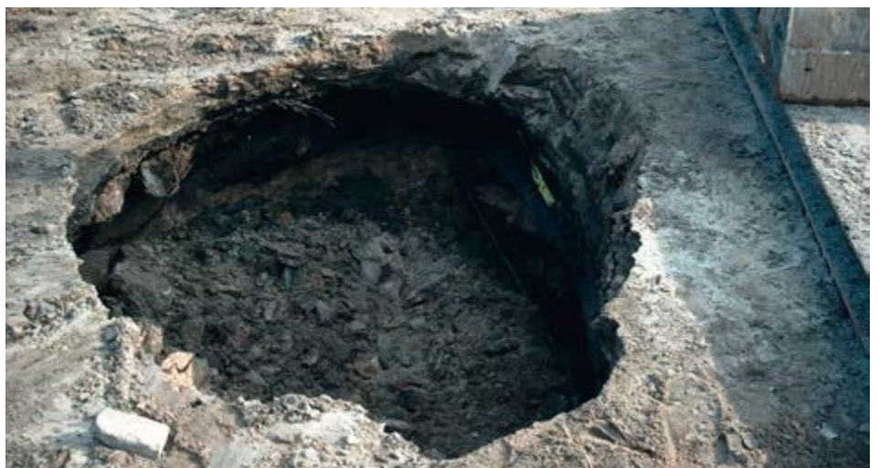
Um Setzungsschäden an der Oberfläche zu verhindern, muss beim Rohrvortrieb Mehraushub zuverlässig ausgeschlossen werden. (Foto: Dr. Uffmann)
