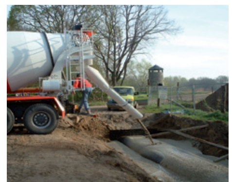
© IAB, Abb. 5 | Einbau mittels Fahrmischer
