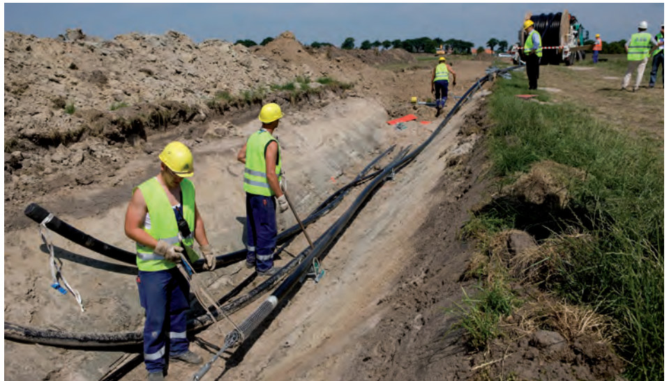
Trasse HGÜ-Kabel (Foto: ABB AG)
