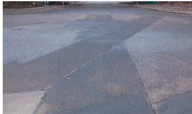
Aufgrabungen im Fahrbahnbereich.
