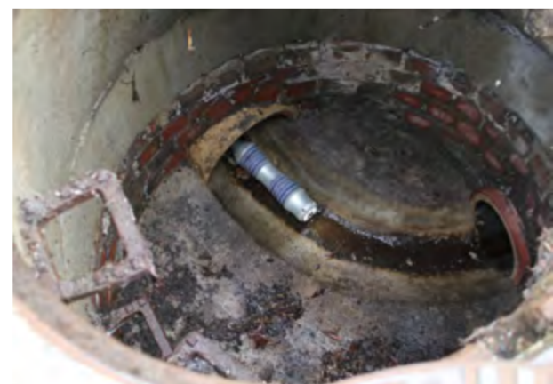
Optische Inspektion mittels Schiebekamera. (Foto: rbv)
