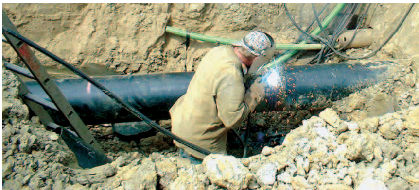
Abb. 2 ■ Schweißerarbeiten am Stahlrohr unterliegen den Anforderungen des DVGW-Arbeitsblattes GW 350 und der DIN EN 12732.
