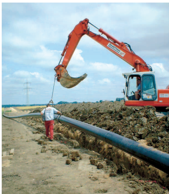
Abb. 1 ■ Verlegestrecke für Gasrohrleitungen.
