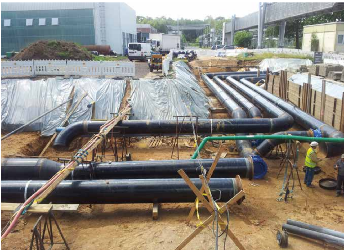
Umfangreiche Tiefbauarbeiten: Im Rahmen des Projektes Medien 2010-Kühlwasser soll insbesondere die Leistungsfähigkeit der DLR-Infrastruktur für die Kühlwasserversorgung gesteigert werden. Foto: ARGE DLR Köln
