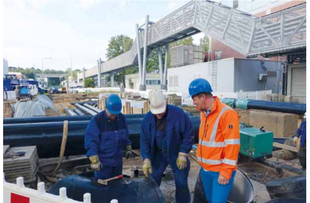
Detlef Schwager, Bauleiter Tiefbauarbeiten (r.), beim Rundgang über die Baustelle.
