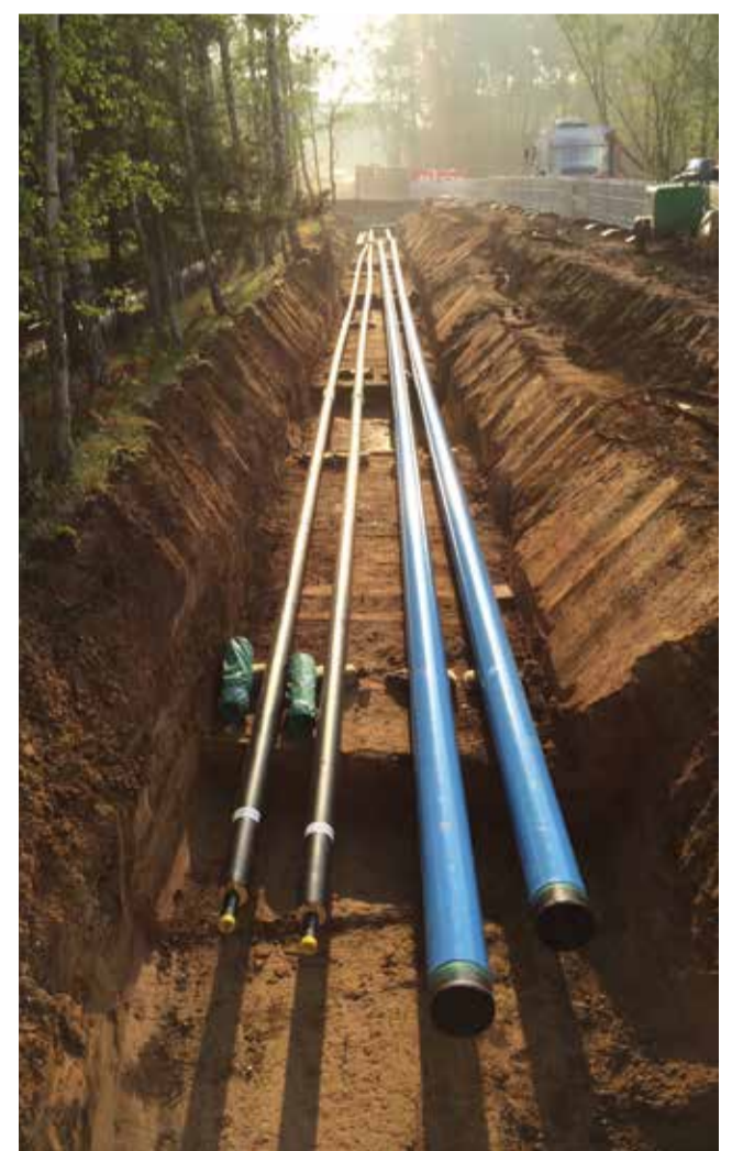
Verlegung von Kunststoffmantelrohren (KMR) DN 65 und PE-HD-Leitungen Da 225. Foto: ARGE DLR Köln
