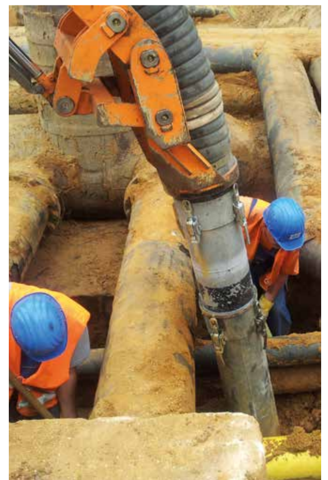
Freilegung vorhandener Leitungen mit dem Saugbagger. Foto: ARGE DLR Köln
