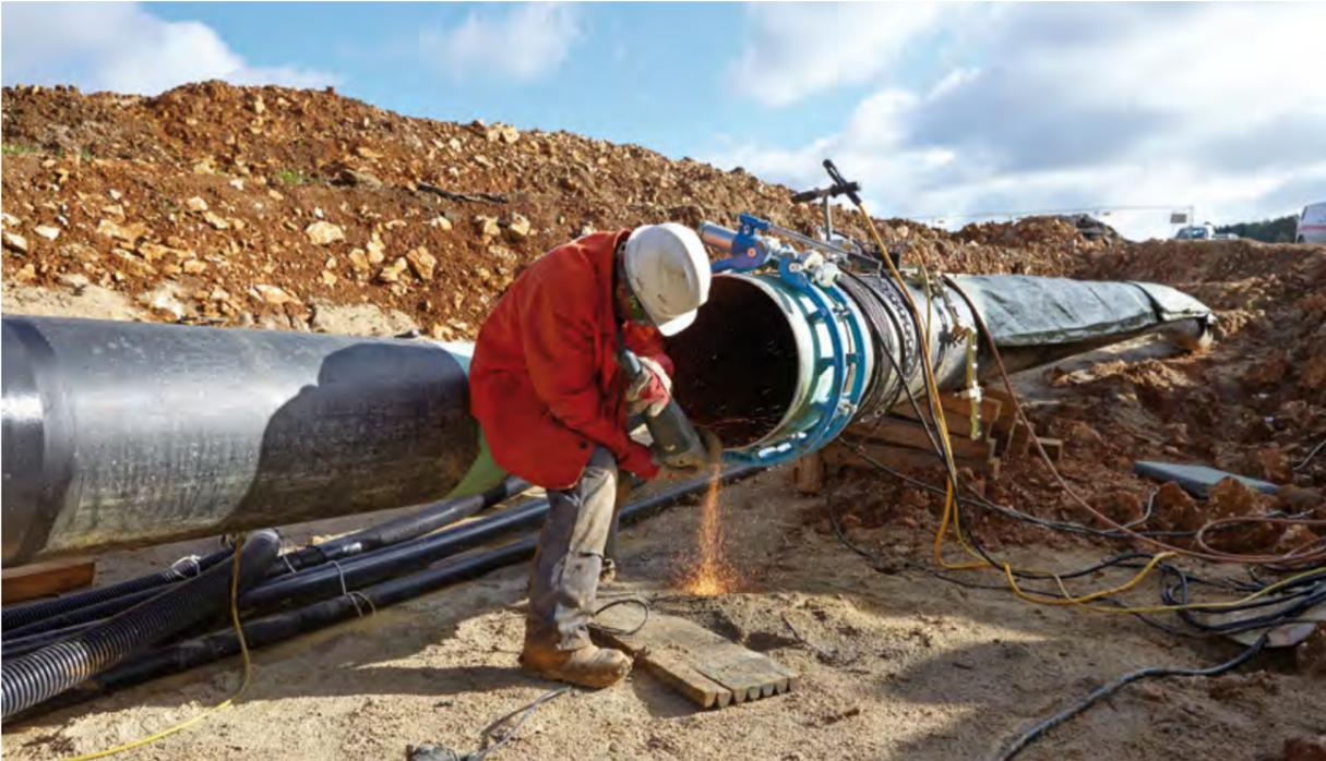
**Eine exakte Schweißnahtvorbereitung ist die Voraussetzung für saubere und sichere Ergebnisse. Zusätzlich zur regulären Ultraschall- und Röntgenprüfung wurden die Schweißnähte nach einem neuen und innovativen Verfahren geprüft. (Fotos: terranets bw)**
