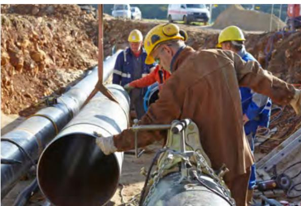
**Einbau eines Passstückes: Die Rohrleitungsbauer der Köster GmbH verlegten auf einer Strecke von 150 m die Gashochdruckleitungen DN 400 MOP 70 und DN 500 MOP 70.**
