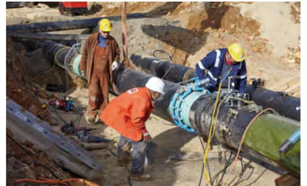
**Die eingebundenen Passstücke weisen eine verstärkte Wandung auf, um die Anforderungen an die Tragfähigkeit zu erfüllen.**
