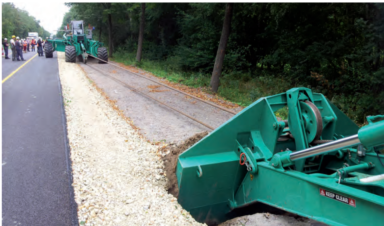
Für den Einbau der Sole- und der Rohwasserleitung entlang der B 70 entschieden sich der Auftraggeber, die Salzgewinnungsgesellschaft Westfalen mbH, und der Auftragnehmer, die RN Rohrleitungsbau Niederrhein GmbH, das Pflugverfahren einzusetzen. Im Vordergrund ist das Abstützschild der Seilwinde zu erkennen. (Fotos: Rohrleitungsbau Niederrhein)
