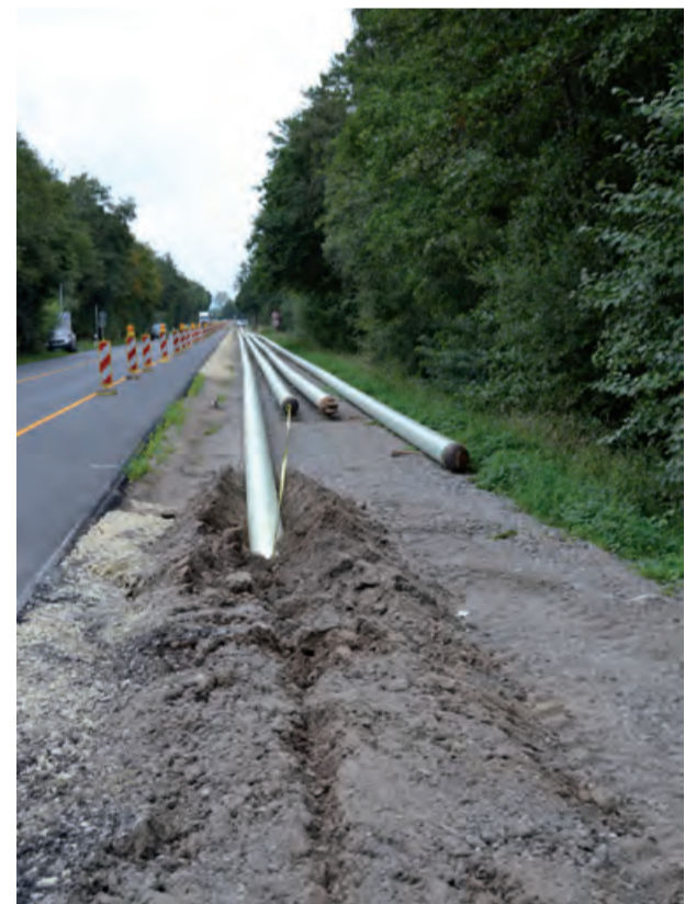
Kontinuierlich wird der Rohrstrang in den Boden eingezogen.
