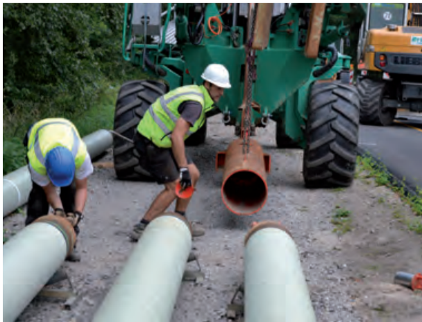
Nach der Fertigstellung der Teilstränge wurde jeweils ein Strang über das Zugrohr an das Schwert des Pfluges angeflanscht. Im Zugrohr befindet sich eine Messapparatur, die die Zugkräfte während des Einbaus aufzeichnet.
