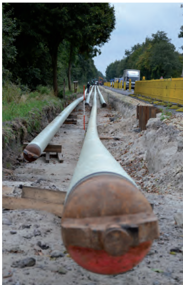
Vor dem Einzug wurden die einzelnen 15,5 m langen Stahlrohrleitungen zu Teilsträngen zusammengeschweißt. Die mit dem Pflugverfahren einzubauenden Rohrleitungen erhielten eine zusätzliche GFK-Umhüllung, um eine Beschädigung der PE-Umhüllung zu vermeiden.
