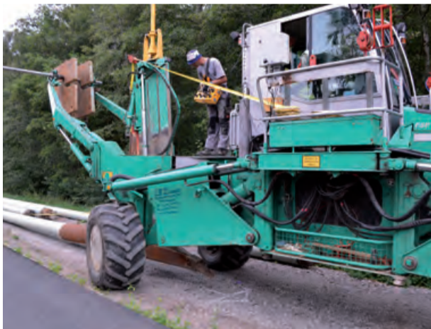
Der Maschinist bringt das Schwert des Pfluges in die Ausgangsposition.
