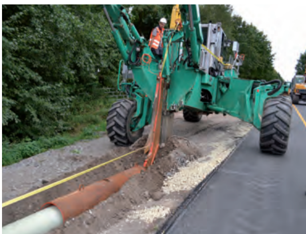
Gleichzeitig mit der Rohrleitung wird ein Trassenmarkierungsband oberhalb der Leitung eingepflügt.
