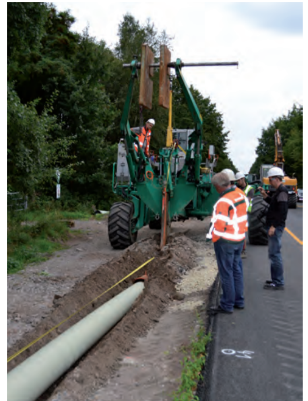
Interessiert beobachten Ralf Nordmann, Salzgitter Mannesmann Line Pipe GmbH und Dipl.-Ing. Winfried Schilling mit weiteren Mitarbeitern die ersten Meter des Rohreinzugs
