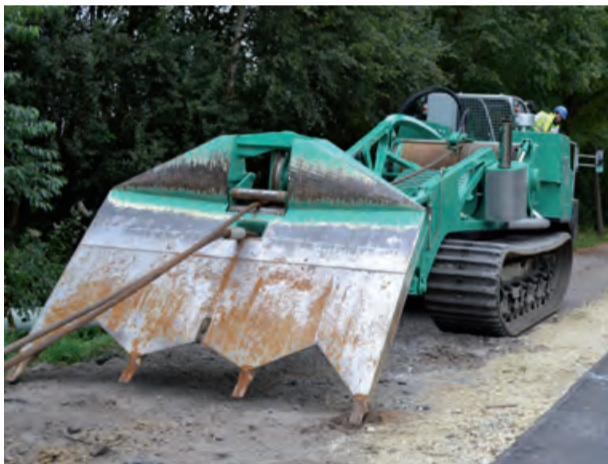
Mit der schweren, fahrbaren Seilwinde wird der Pflug mit dem angeflanschten Rohrstrang kontinuierlich nach vorne gezogen.
