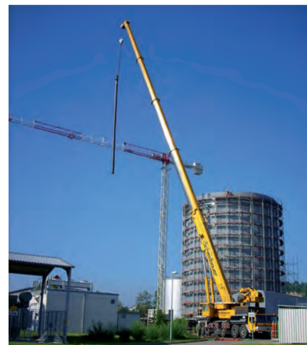
Einheben der Be- und Entladeleitung in den Kältespeicher Biberach
