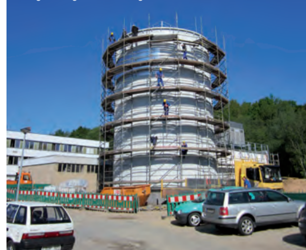
Blick auf den Kältespeicher für das Klinikum Chemnitz nach Fertigstellung der Isolierung
