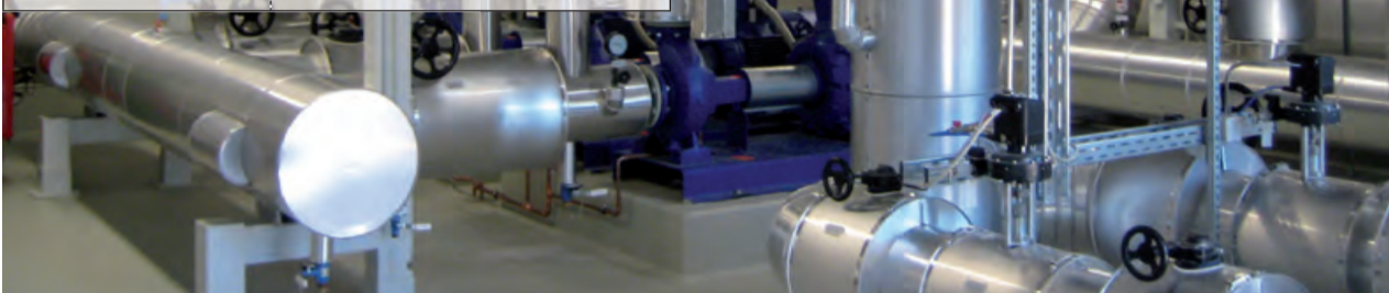
Blick in das Funktionsgebäude des Kältespeichers in Biberach
