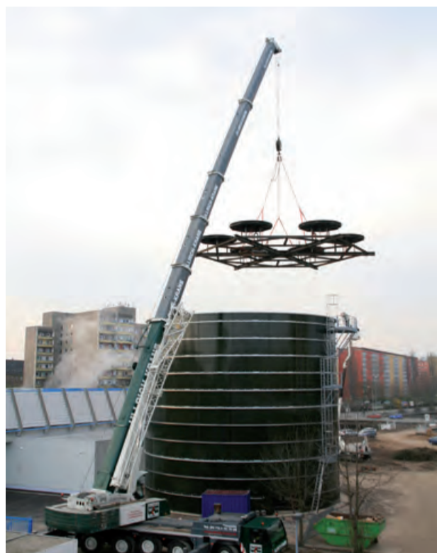
Einheben der oberen Be- und Entladesysteme in den Kältespeicher Georgstraße Chemnitz
