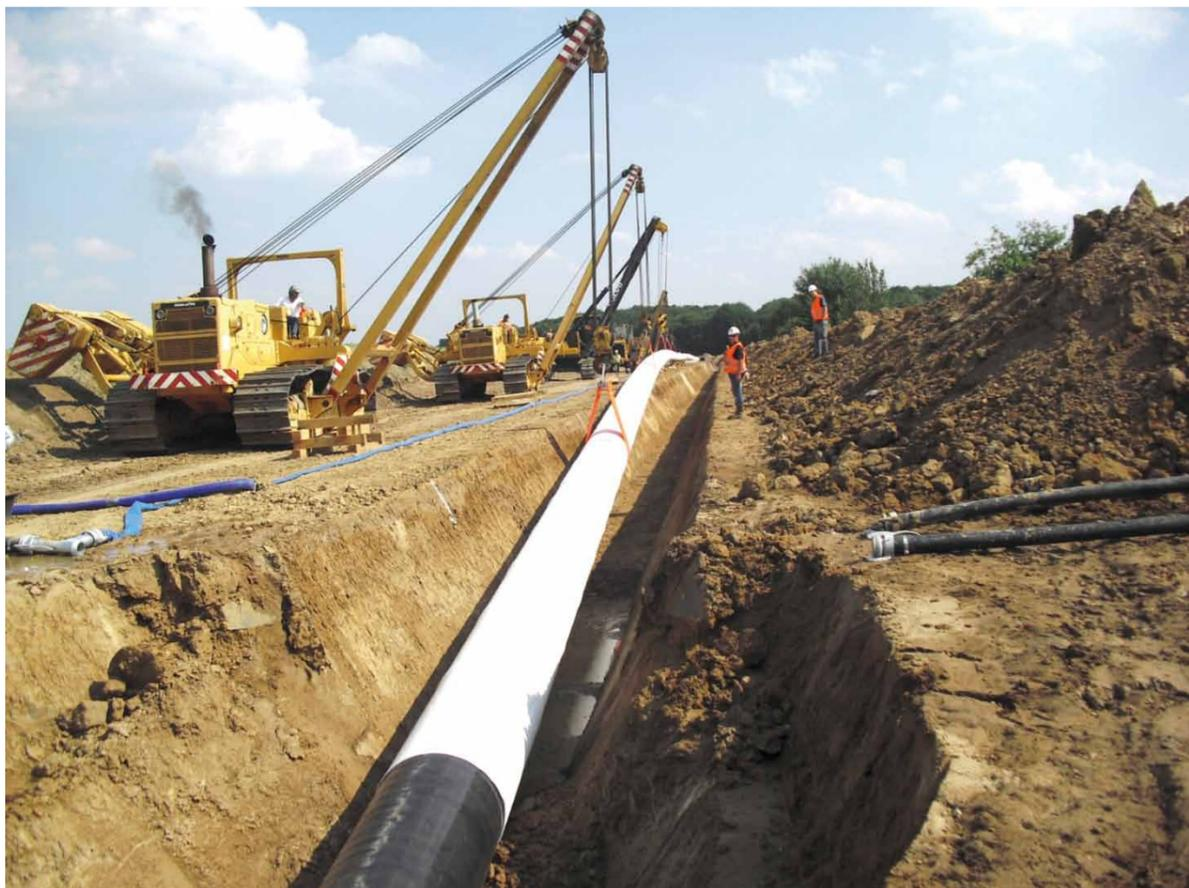
Bau der Gashochdruckleitung (DN 800) zwischen der Obertageanlage in Peckensen und dem Netzkopplungspunkt Steinitz der ONTRAS-VNG Gastransport GmbH.
