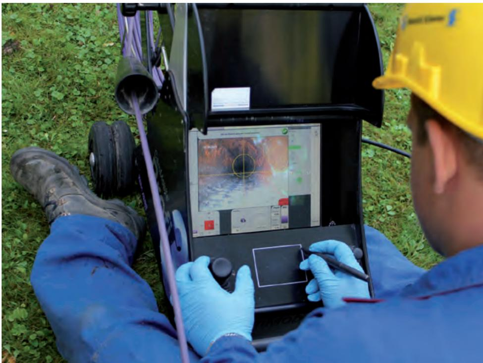
Optische Prüfung der Abwasserleitung durch die Befahrung mit der Kamera
