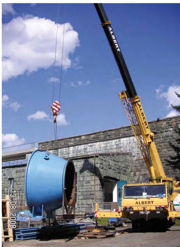
Nach der Demontage wurden die Teile der Ringkolbenventile zur Reparatur und Überholung nach Chemnitz transportiert. (Foto: RAC)
