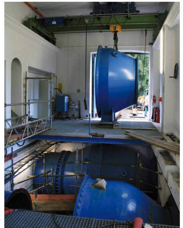
Demontage der Ringkolbenventile: Ausbau des wasserseitigen Gehäuses. (Foto: RAC)
