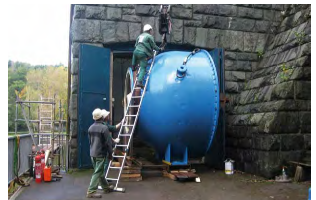
Regelrechte Millimeter-Arbeit: Ausbau des luftseitigen Gehäuses mit Plungerkörper. (Foto: RAC)
