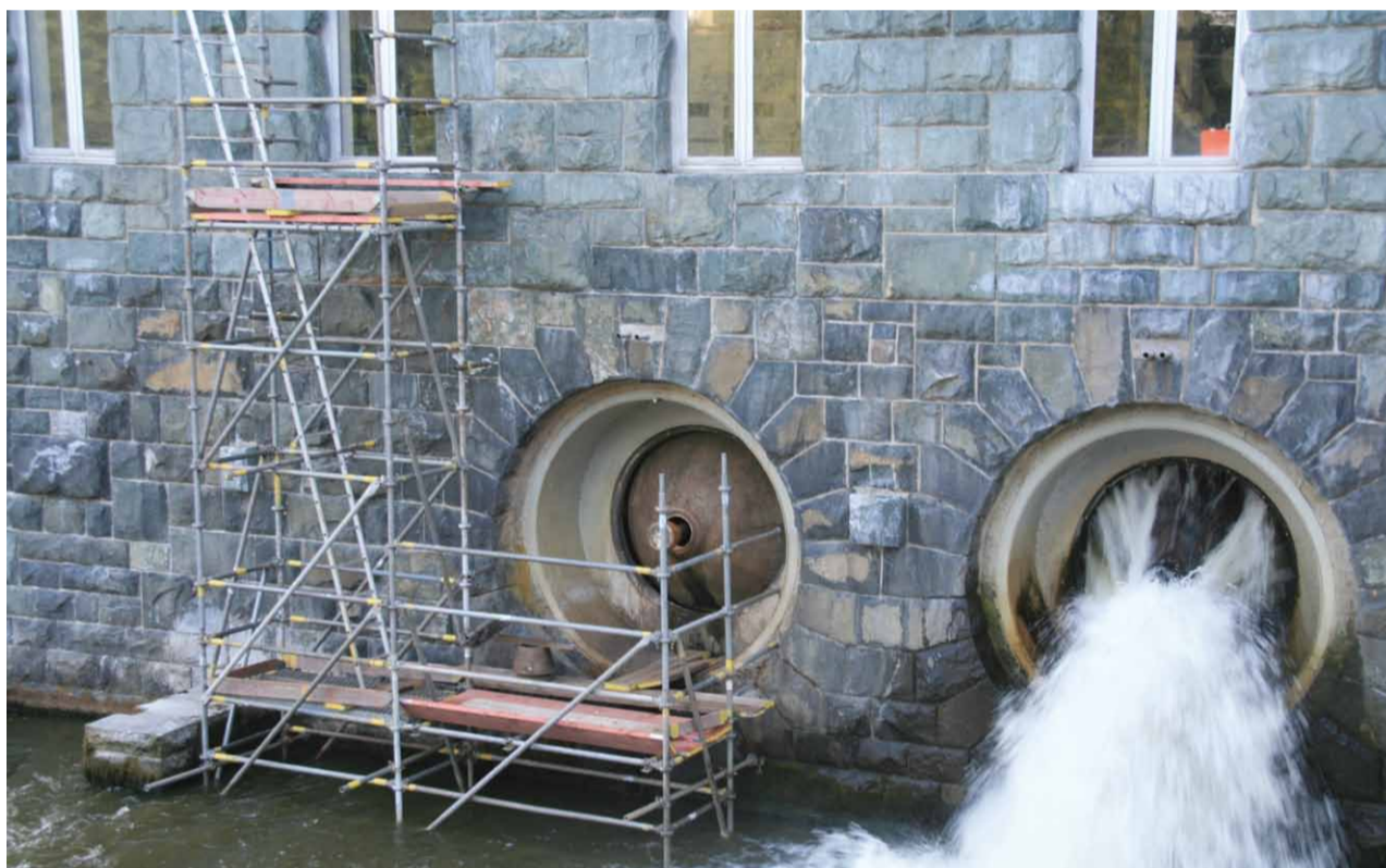
Die Talsperre Pirk ist mit zwei parallel angeordneten Grundablassleitungen ausgestattet. Diese werden durch hydraulische Ringkolbenventile geregelt. (Foto: RAC)
